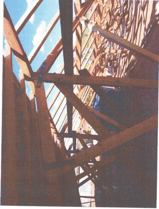
Tesouras com travamento e caixa d'água
