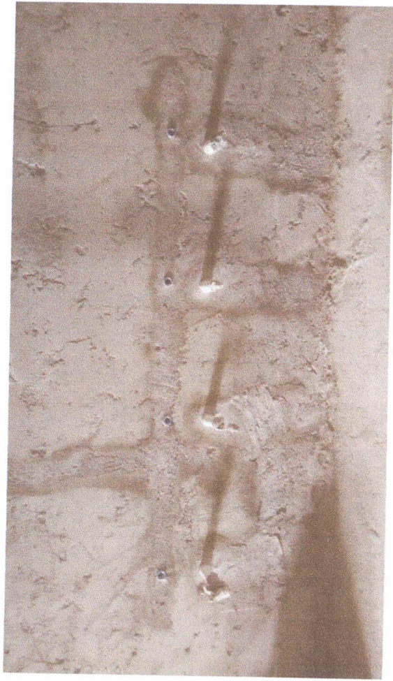
Pontos de água e esgoto.
