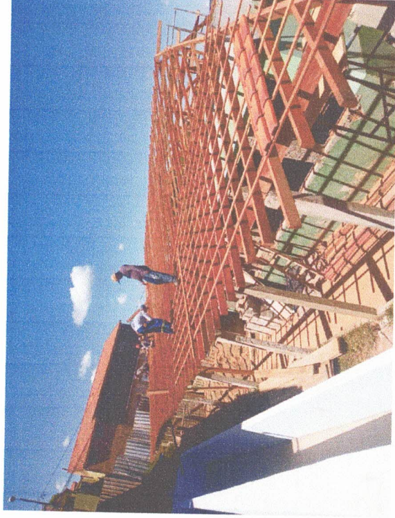
Tesouras com travamento e caixa d'água
