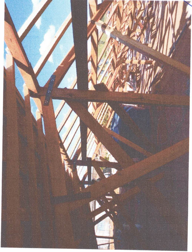
Travamento tesouras e caixa d'água.
